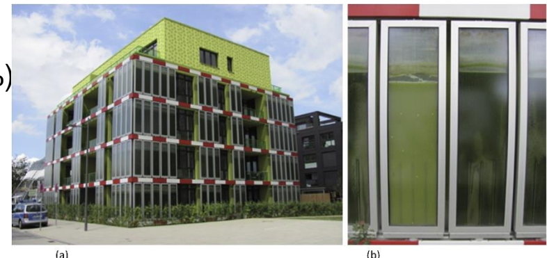
Abbildung 6: (a) BIQ-Haus, Hamburg und (b) die als Fassadenelement verwendete Photobioreaktor-Platte
