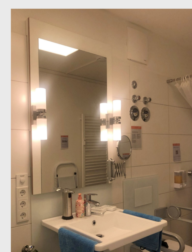
Abb. 3 - 5: Beispiele für „Licht zum Sehen“: links: Nachtlit unter dem Bett; Mitte: Spiegel mit beidseitiger Beleuchtung; rechts: Schrankbeleuchtung mit vertikalen Profilleuchten.
